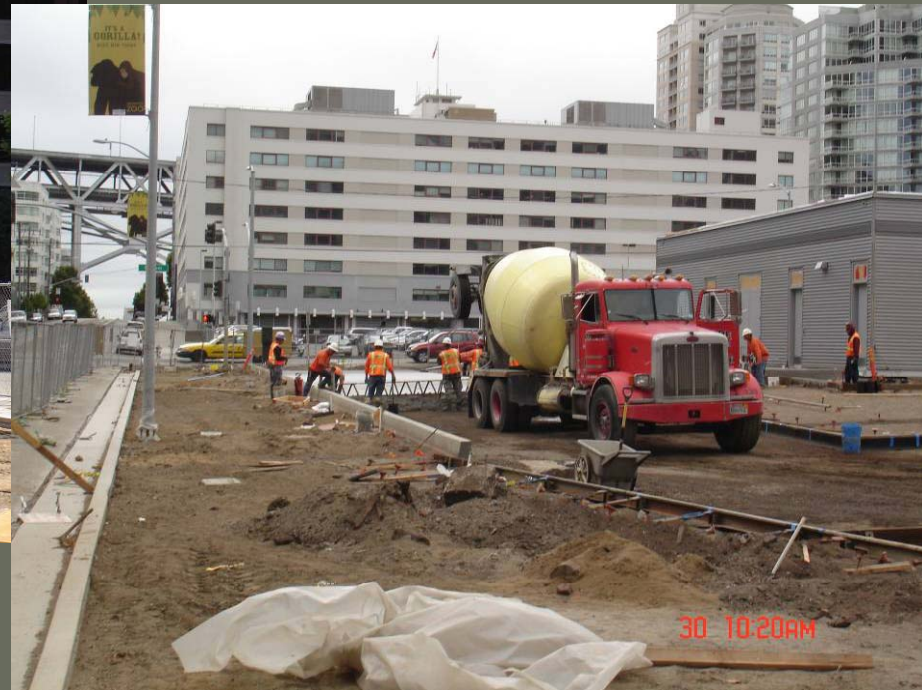
Drive Aisle Pour
