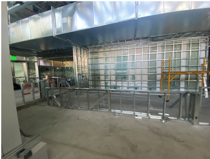
Via Vai ; dry wall framing
